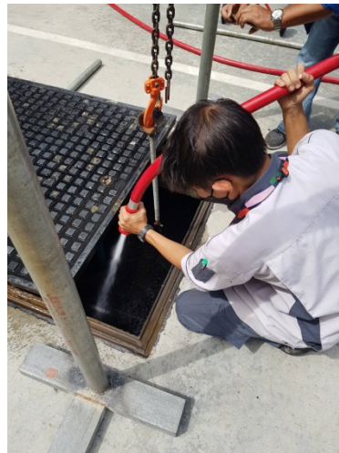
ภาพที่ 4-40 ดูตะกอนที่บ่อเก็บตะกอนของระบบบำบัดน้ำเสีย
