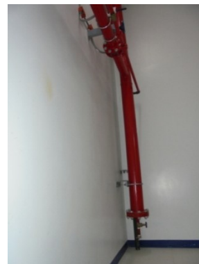
ภาพที่ 4-18 ระบบท่อเย็นของอาคาร และปั๊มสูบน้ำดับเพลิง
