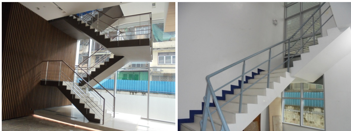
4-25 บันไดหนีไฟและระบบระบายอากาศแบบธรรมชาติ โดยใช้หน้าต่างบานเปิด
