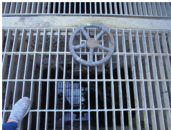
ภาพที่ 4-12 ประตูระบายน้ำแบบมือหมุน กันน้ำจากภายนอกย้อนกลับเข้ามาในโครงการ(Sluice Gate)
